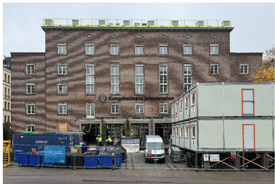
Nyrenoverad fasad, renoverade fönster med nya innerbågar och nya solavskärmningar, nytt tak med solceller och nyomlagda takdetaljer.
